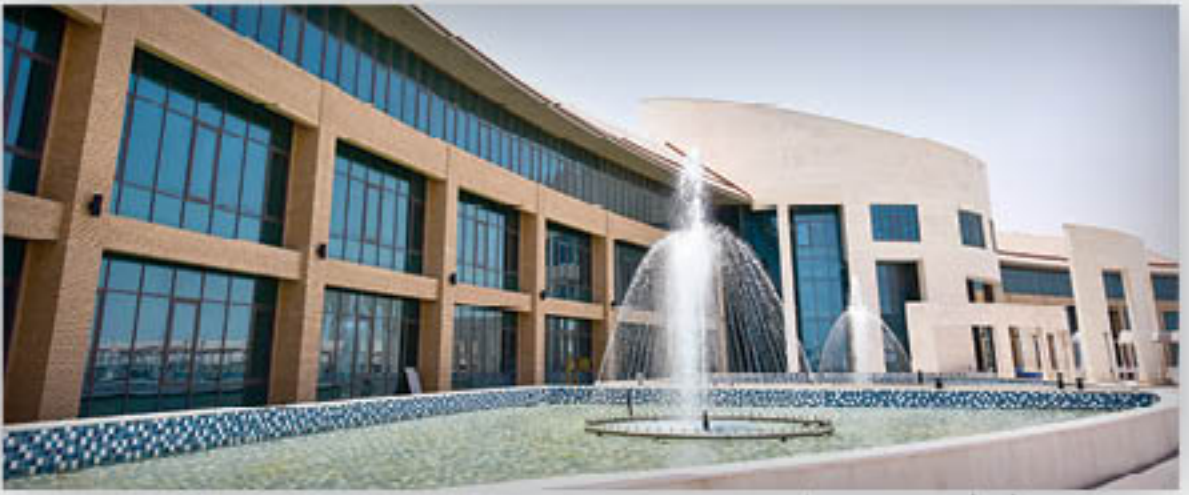
مبنى العمير KOC وأحد الأعمال التي نفذتها الشركة
